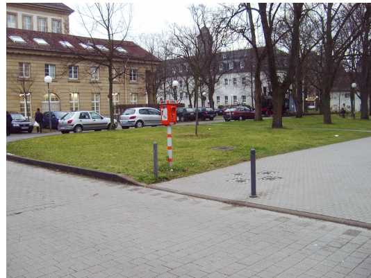
Nr. 2 – Gebäude 10.95 (Paulckeplatz), Engelbert-Arnold-Straße 12
